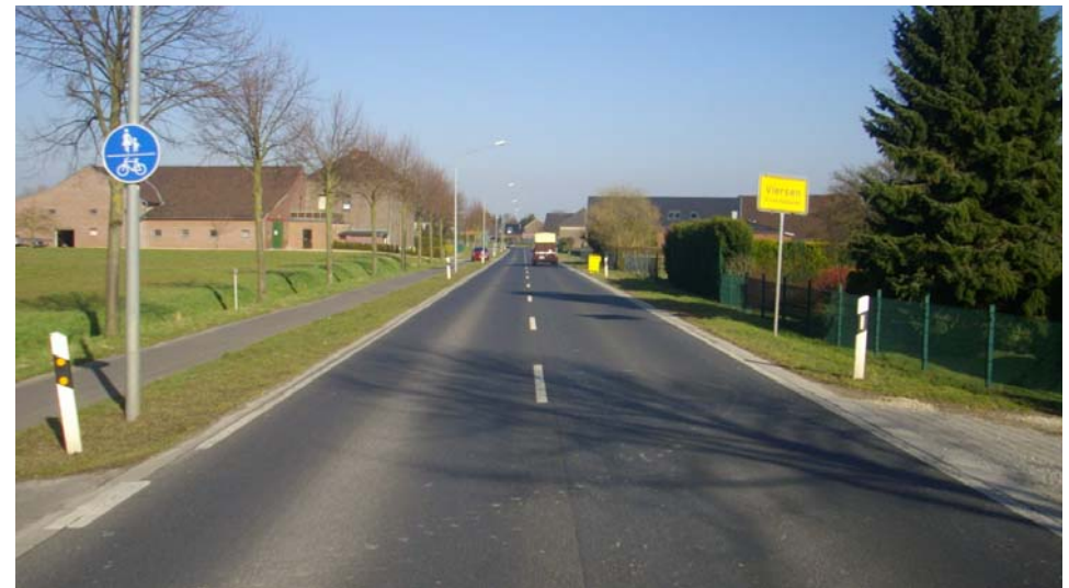
Bild 22: K 8 in der westlichen Ortseinfahrt Mackenstein
